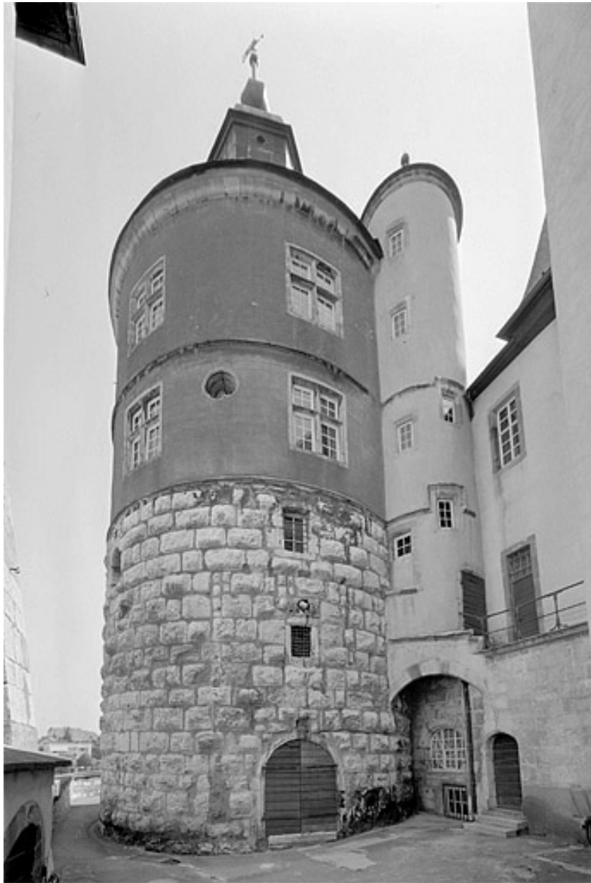
Tour Henriette vue de la cour de l'Ours.
