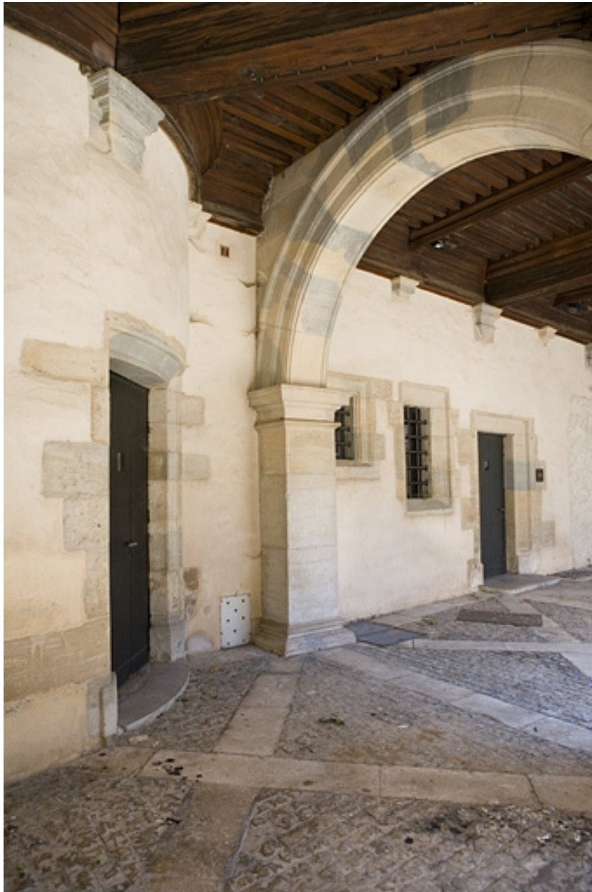
Détail de l'extrémité du portique nord-est.
