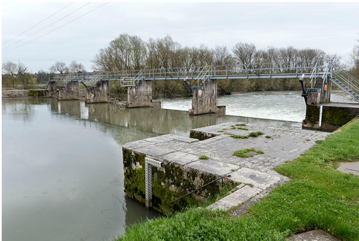
Vue générale du barrage.
