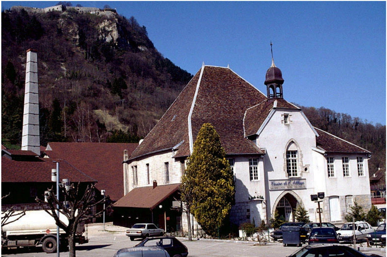
La maison du Pardessus vue de trois quarts gauche.
