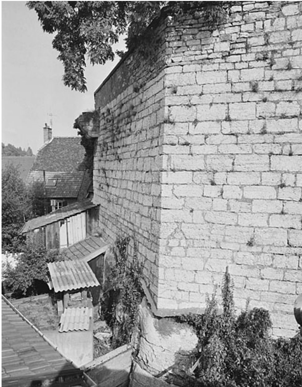
Enceinte. Partie sous le Vieux Château (h).
