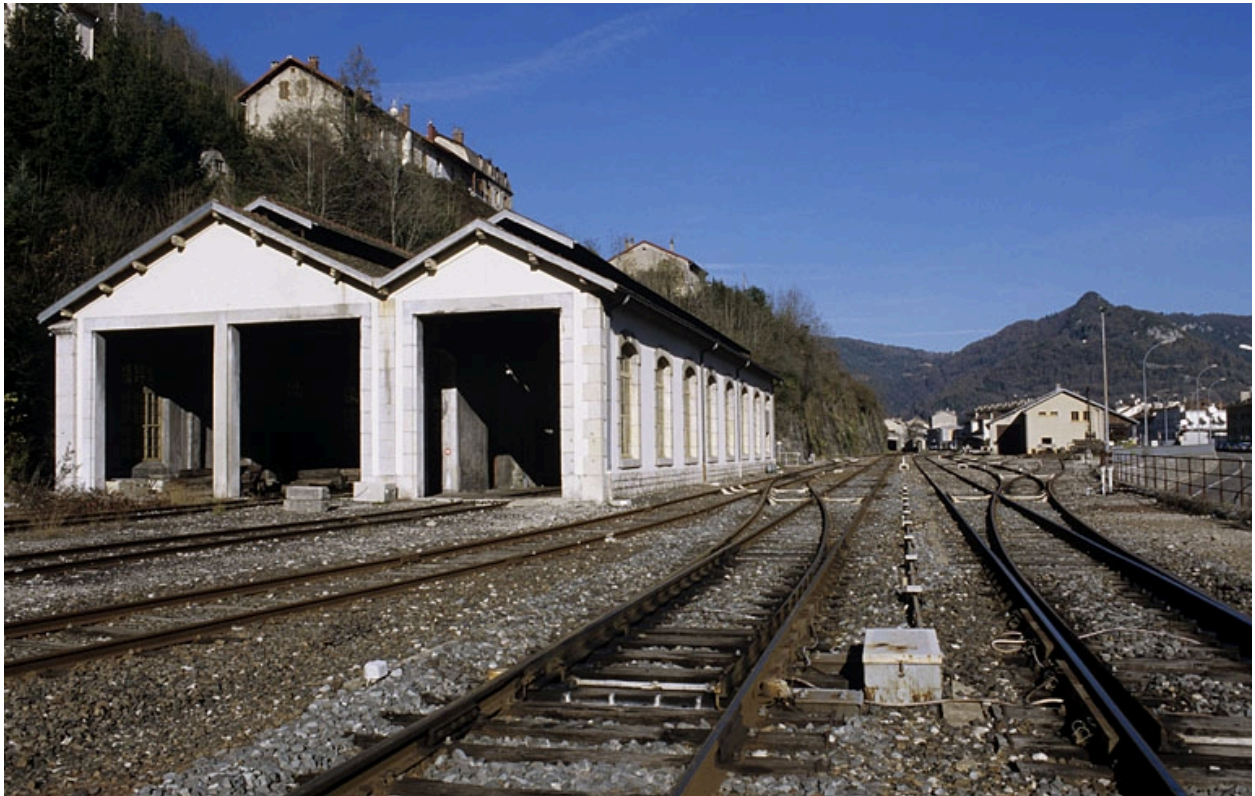
Remise ferroviaire : vue d'ensemble, depuis le sud.
