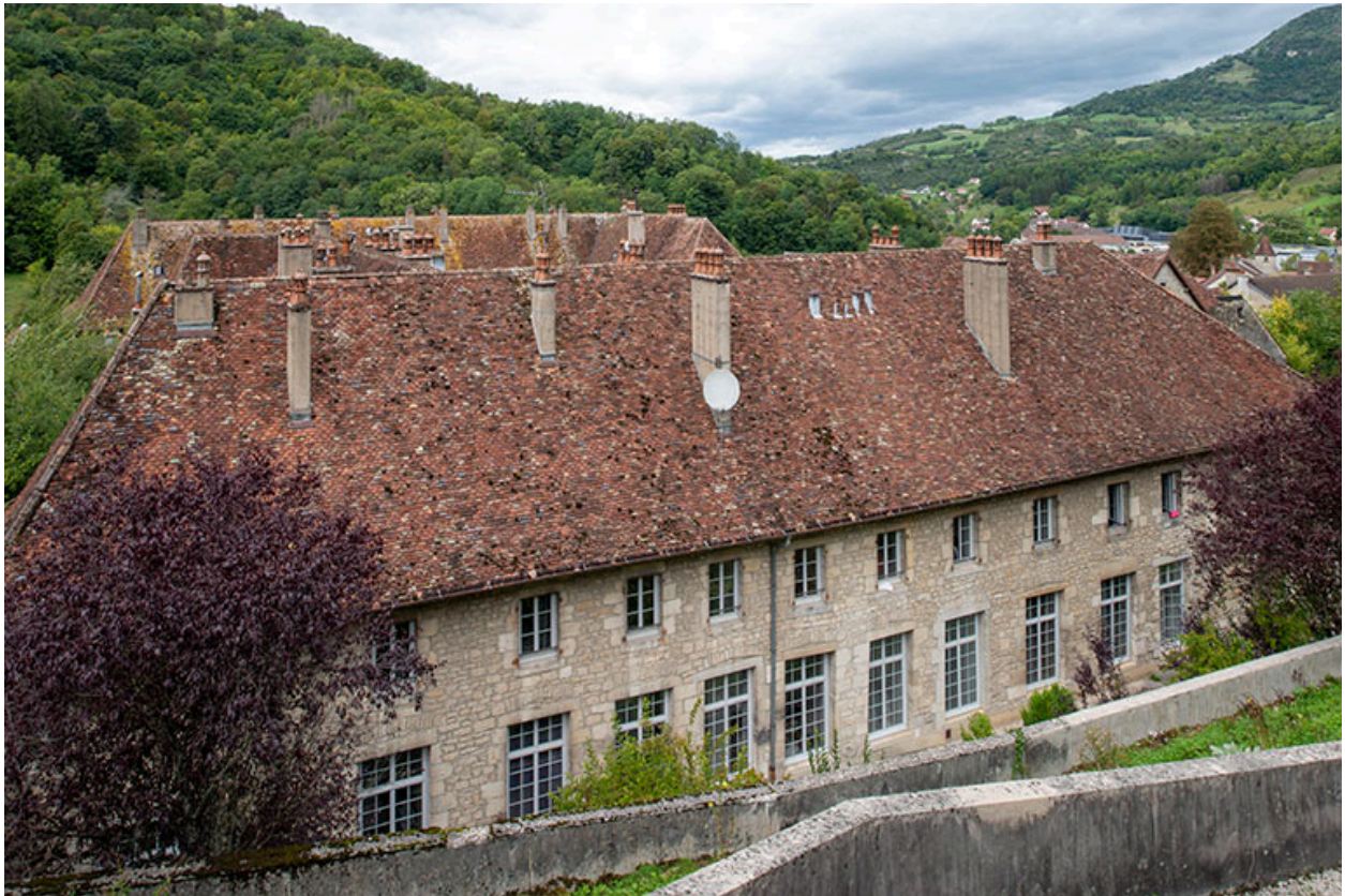
Façade est du bâtiment amont.
