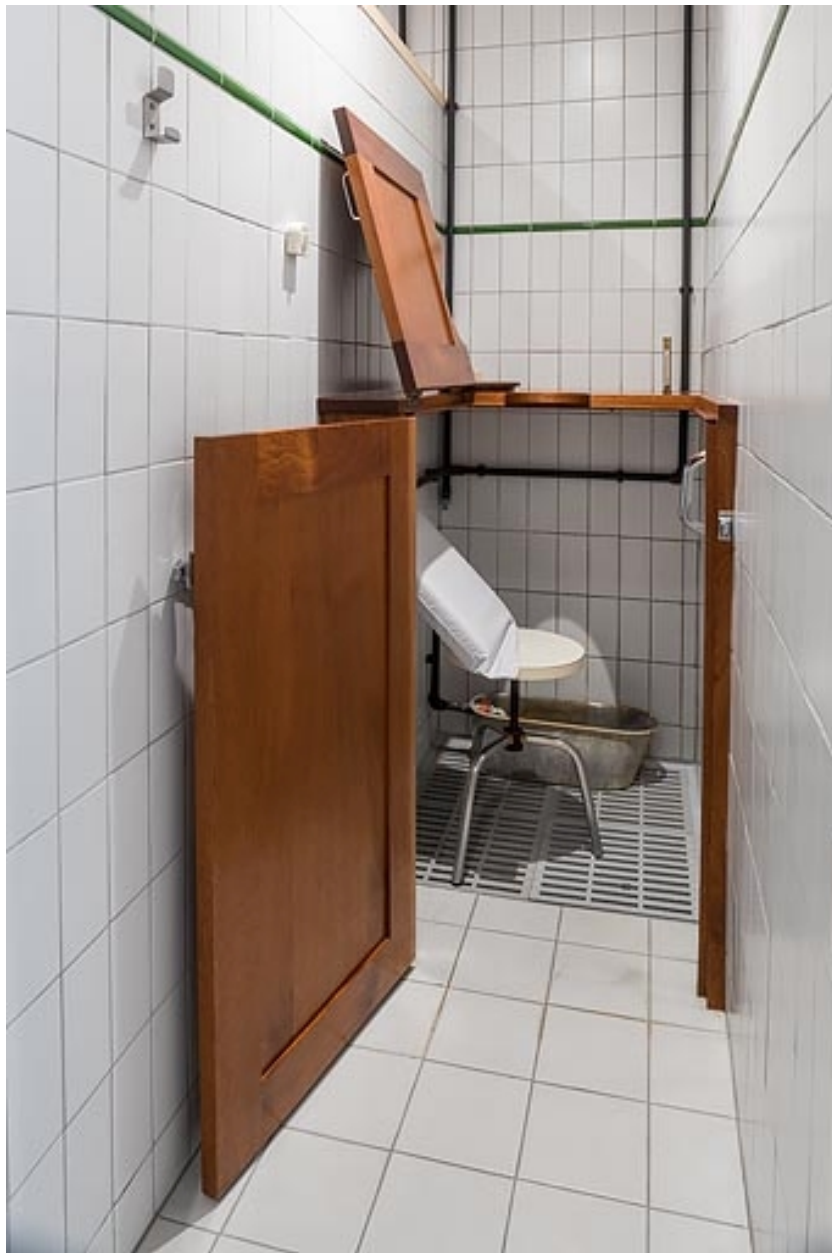
Étuves locales, au rez-de-chaussée (pavillon annexe de 1897).
