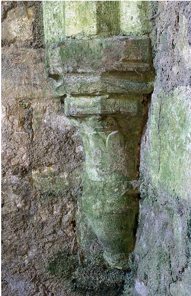
Cellier : rez-de-chaussée, salle nord, chapiteau nord-est.
