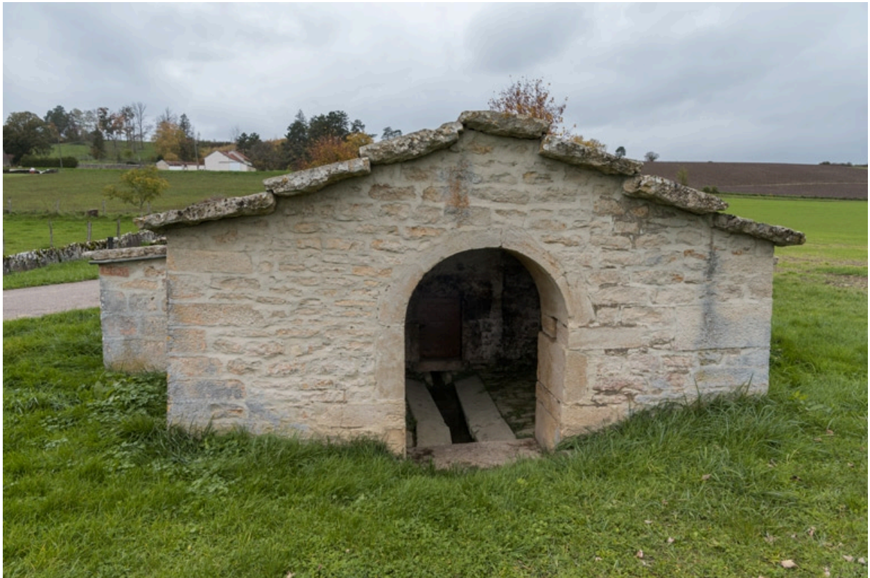
Vue de la façade est.
