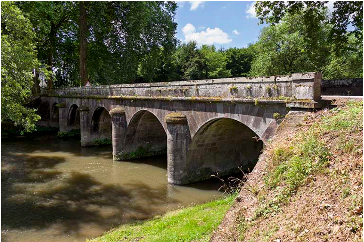
Vue du pont en amont.
