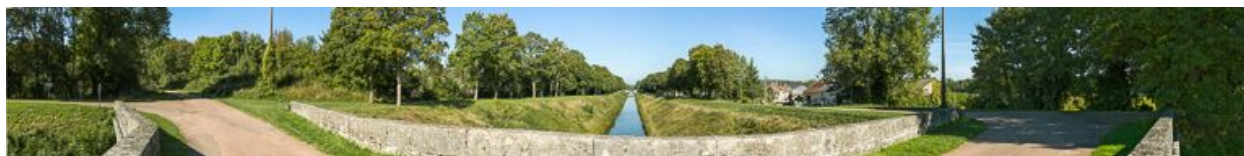
Vue panoramique de la tranchée.
