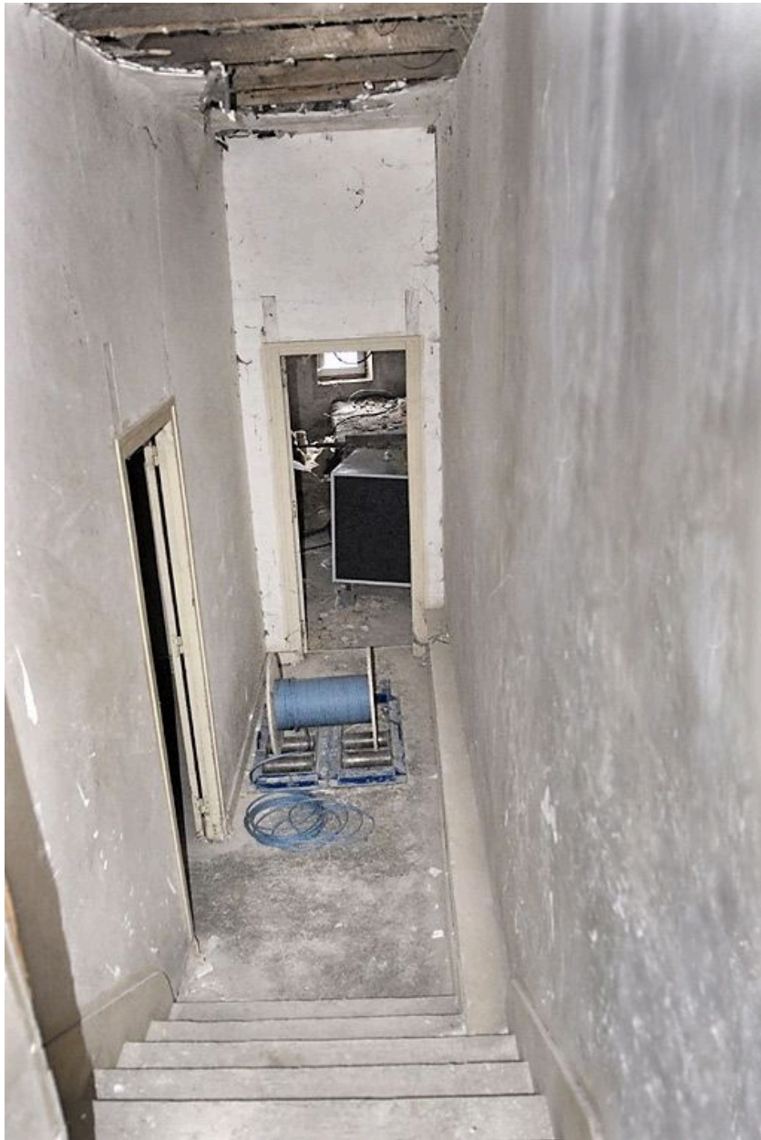
Couloir et escalier pendant les travaux.
