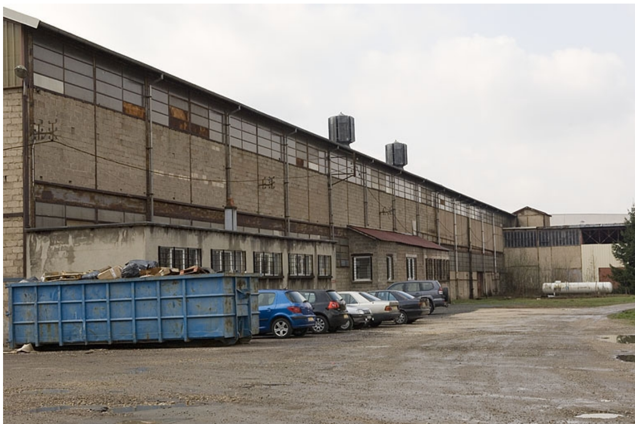
Façade nord de l'atelier de fabrication.
