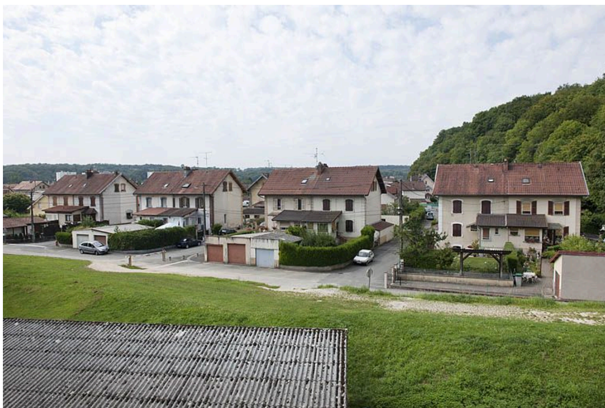
Audincourt, cité ouvrière de la Compagnie des forges dite cité Keller : vue d'ensemble depuis l'est
