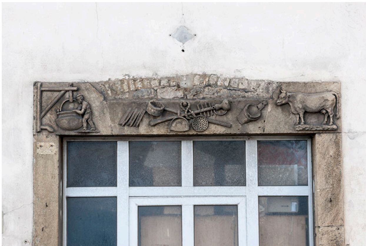
Façade antérieure. Linteau figuré.
