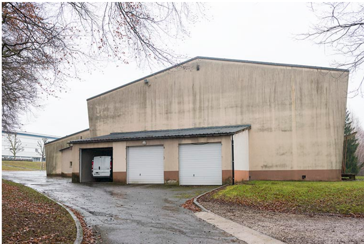
Façade postérieure - ouest - du gymnase.
