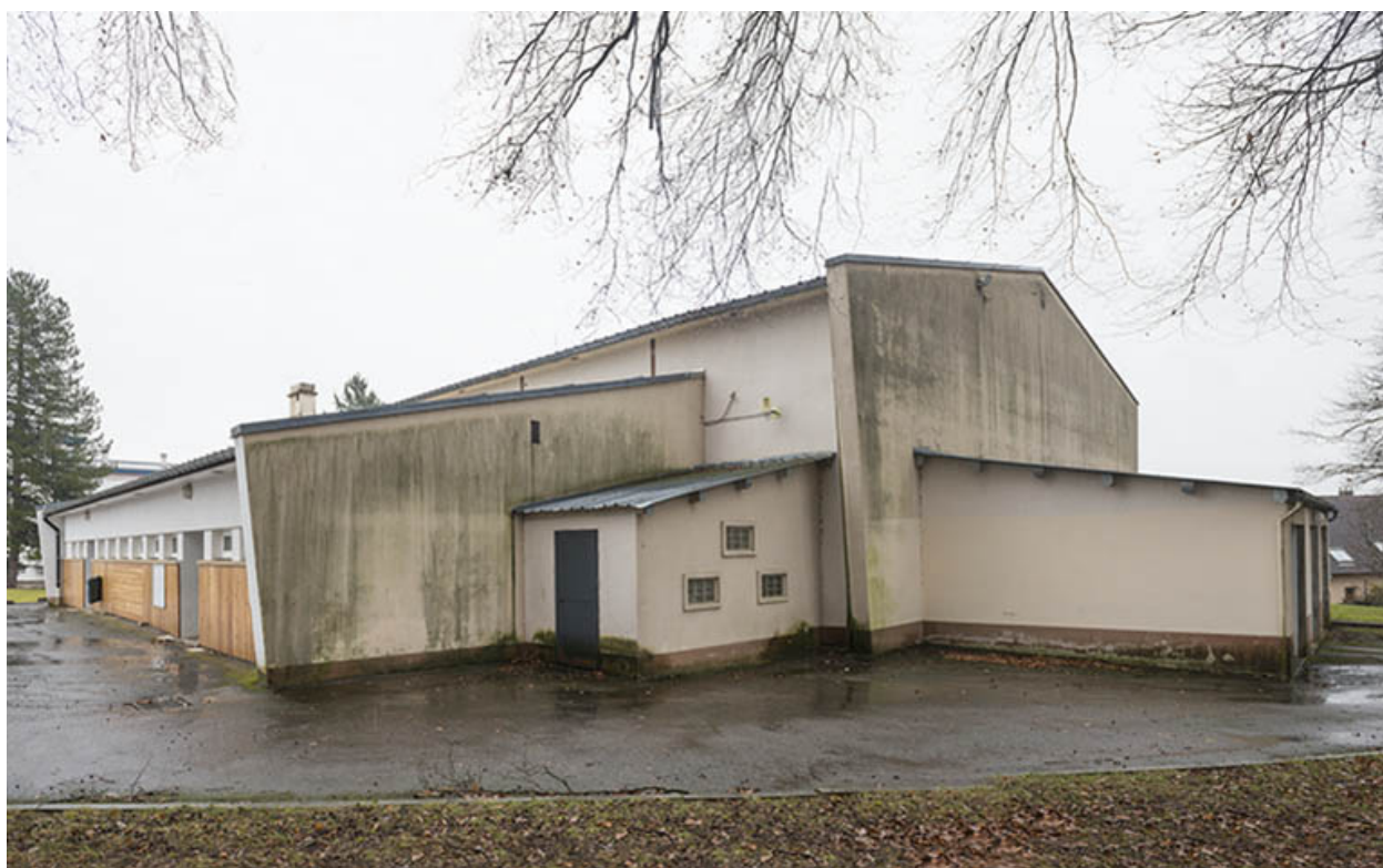
Angle nord-ouest du gymnase.
