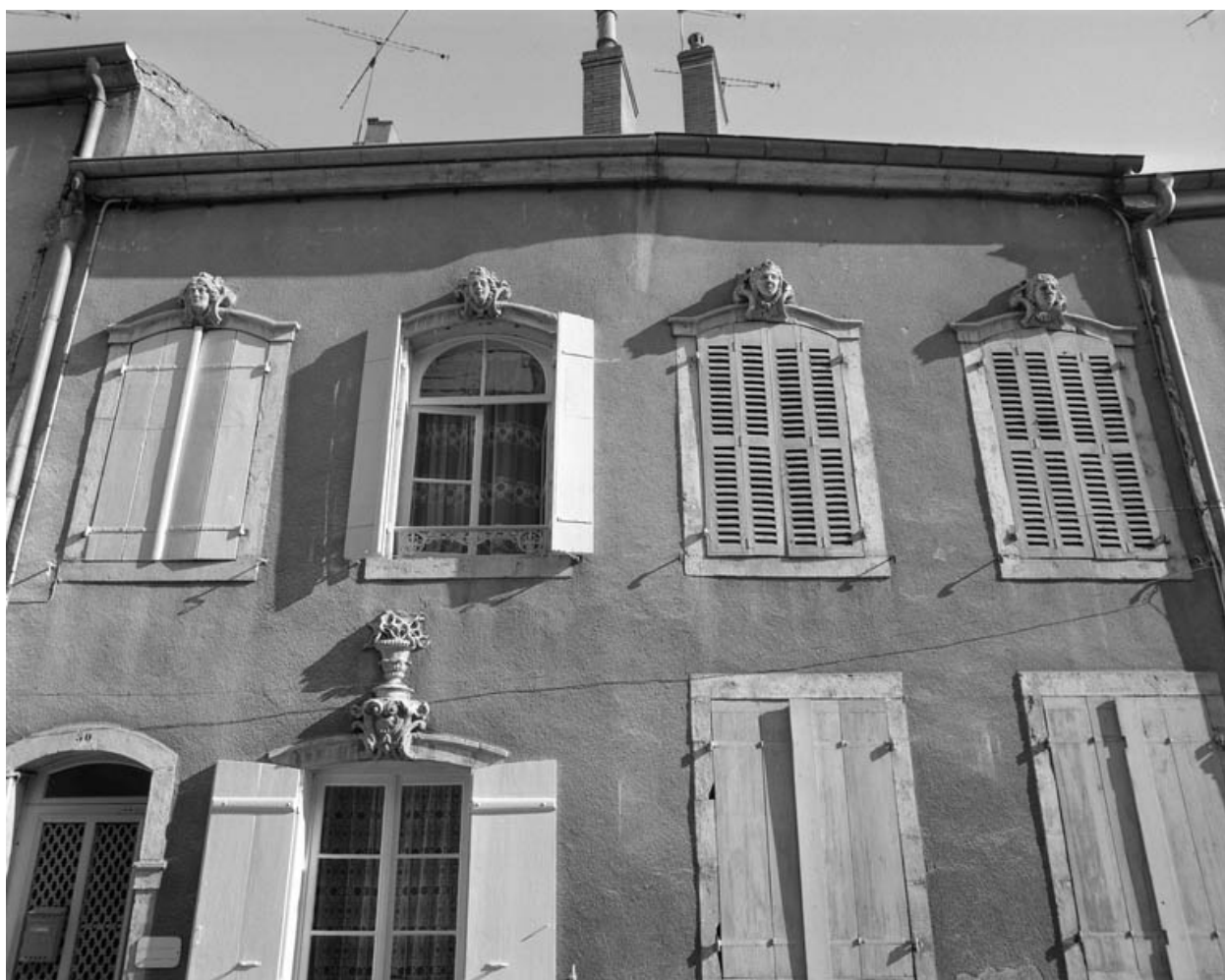
Façade antérieure : baies du premier étage.
