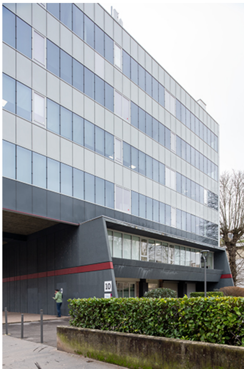
Façade sud-ouest, détail.
