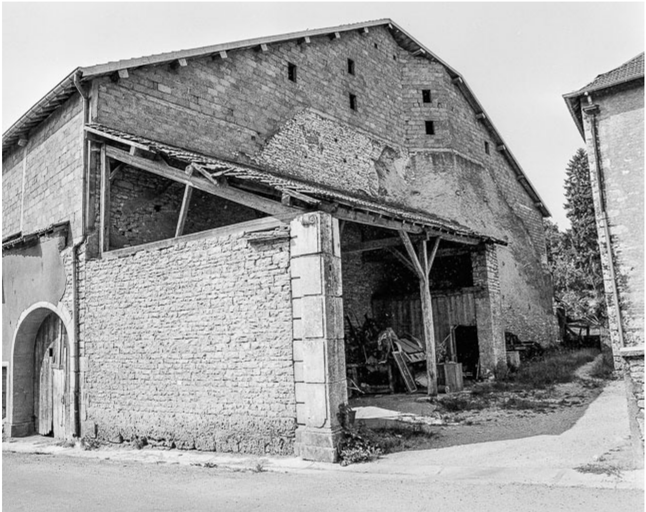
Ferme cadastrée 1973 AB 27 située rue d'Amont à Chenevrey : hangar situé à gauche de la maison.
