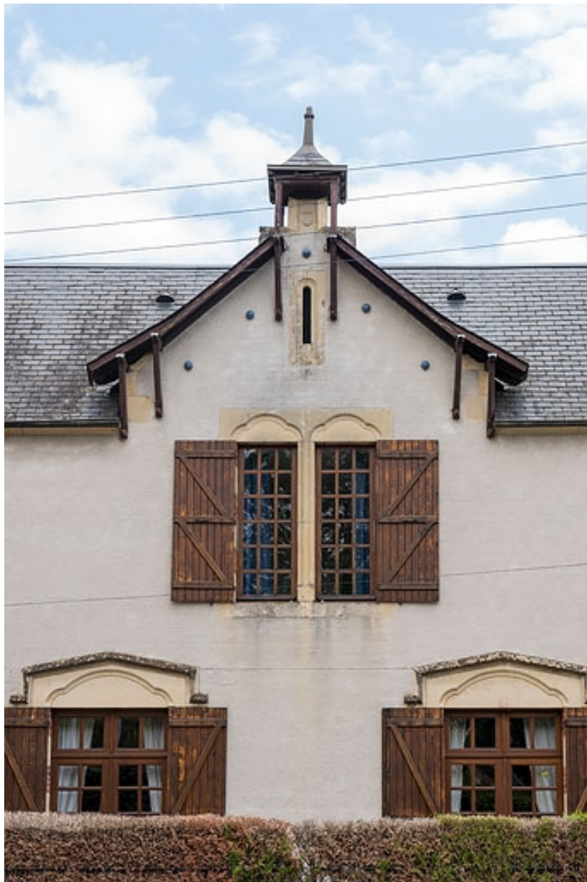
Pignon de la façade principale.
