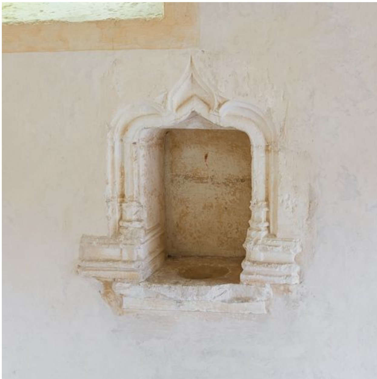
Vue du lavabo, mur droit.
