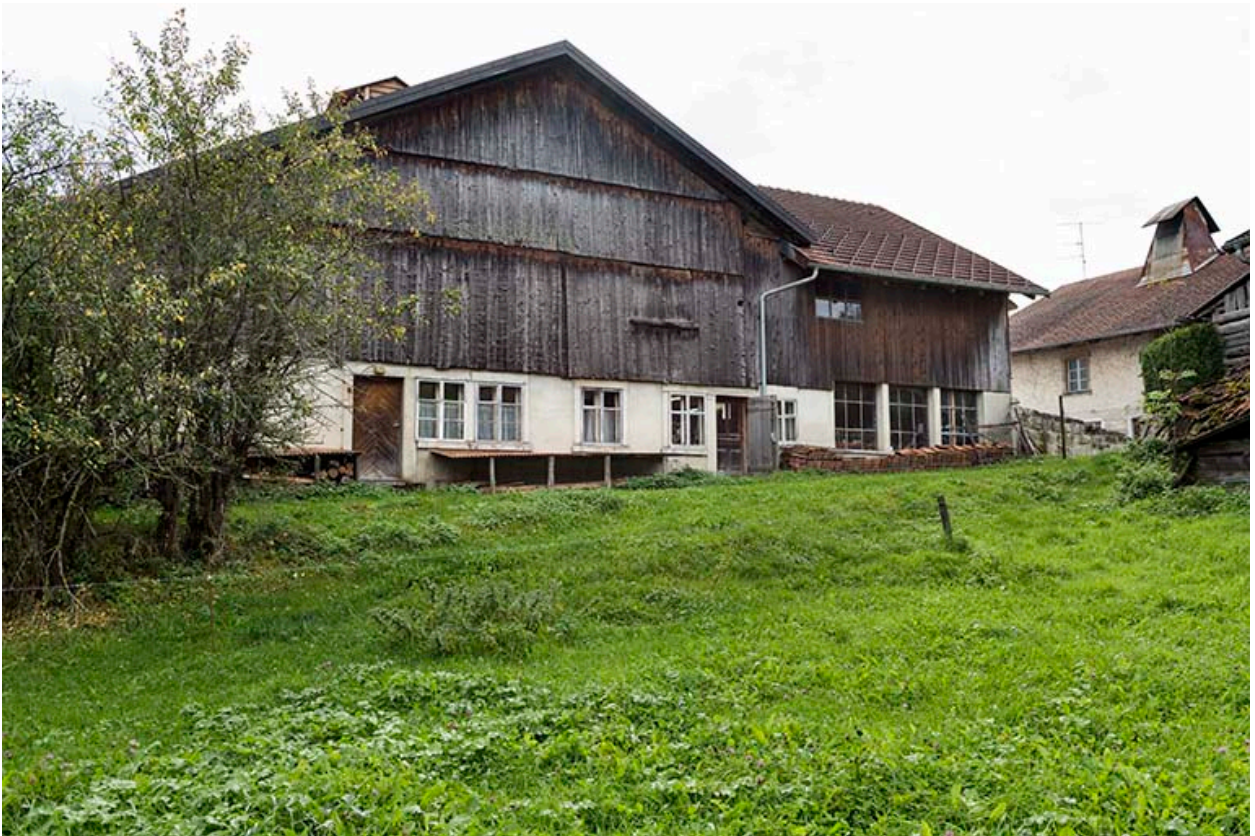
Façade postérieure : vue rapprochée avec les fenêtres de l'atelier de mécanique à droite.
