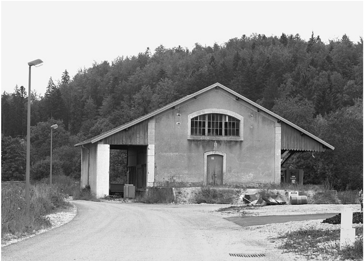
Entrepôt : façade antérieure (nord).
