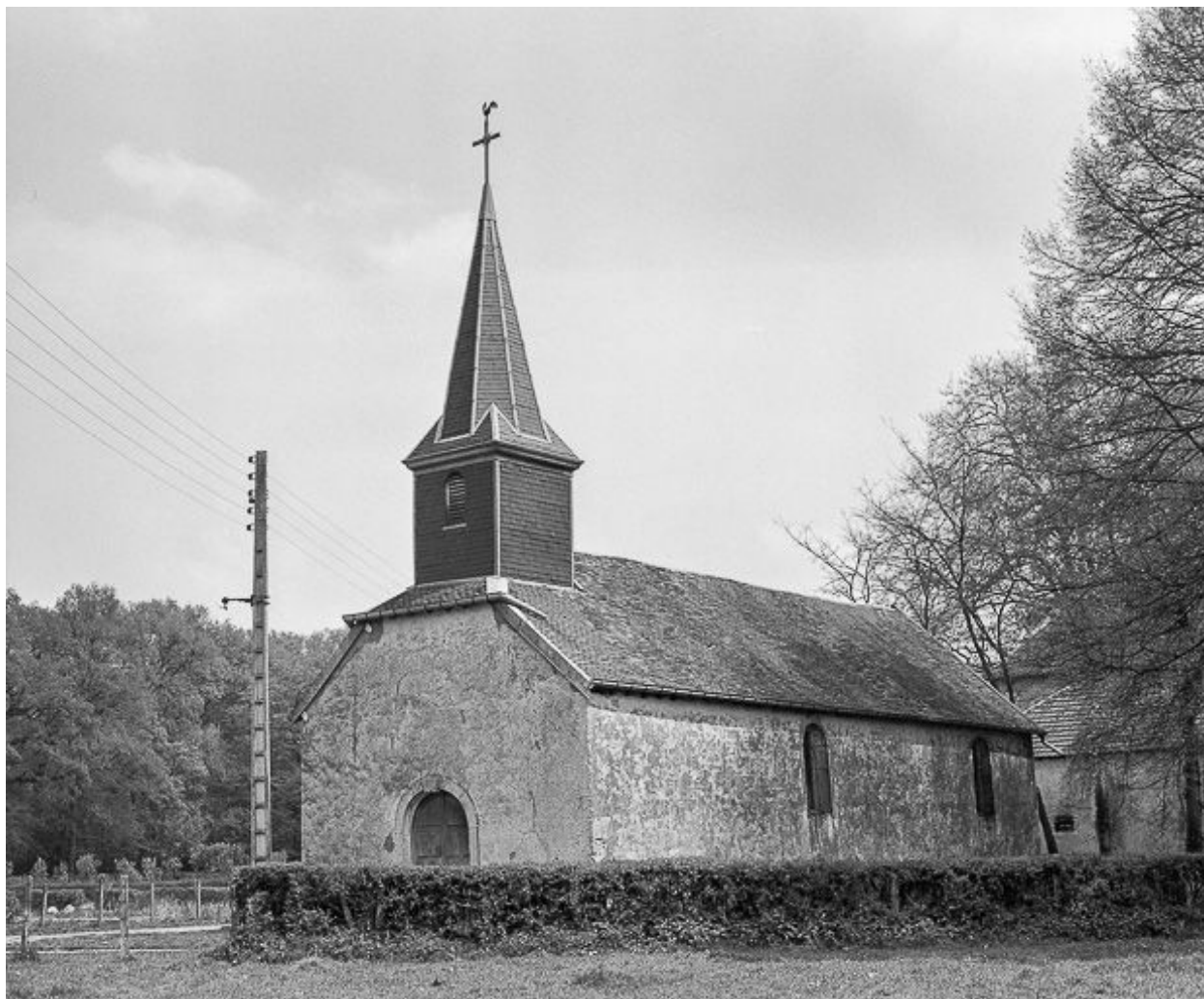
Façades antérieure et latérale droite.
