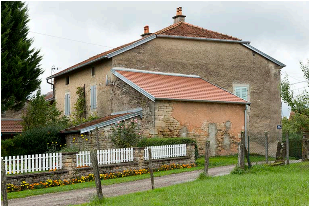
Ferme transformée en maison.
