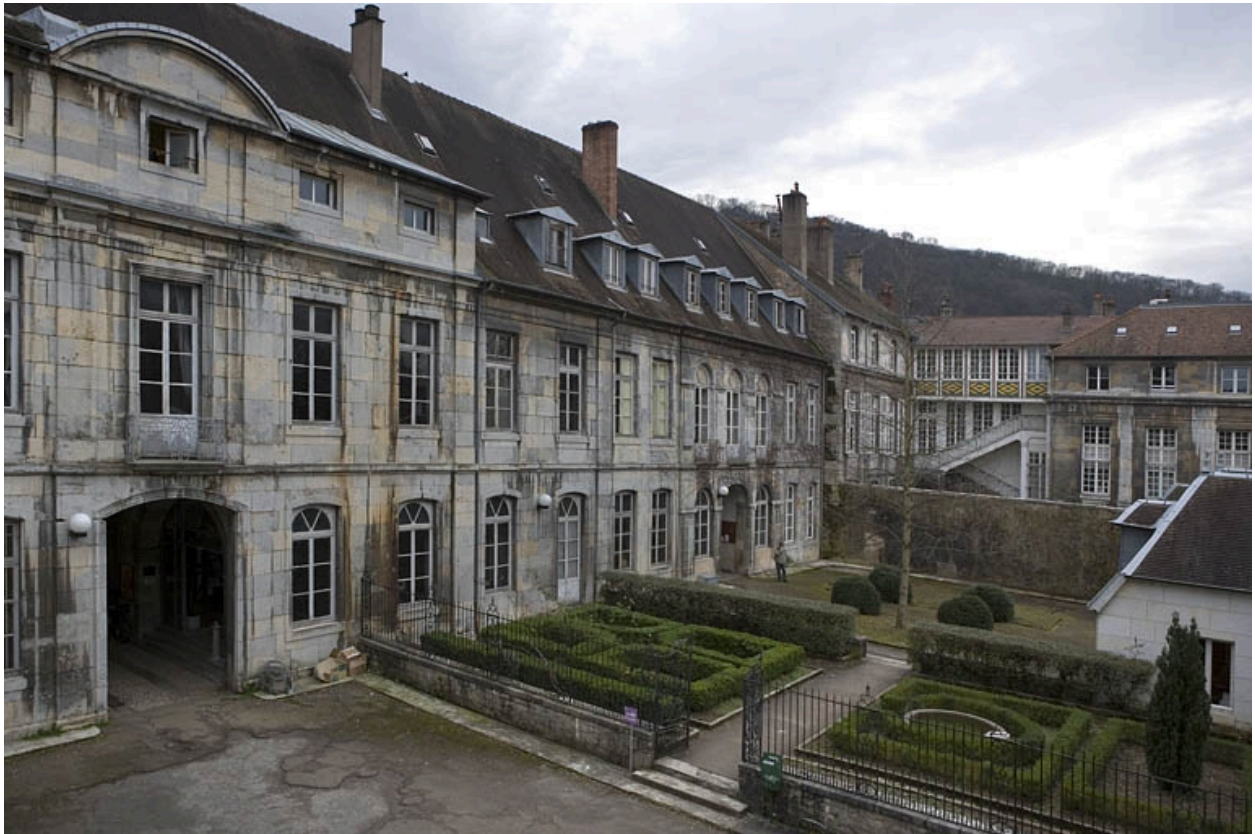
Vue d'ensemble de la façade sur cour et du jardin, de trois-quart gauche.
