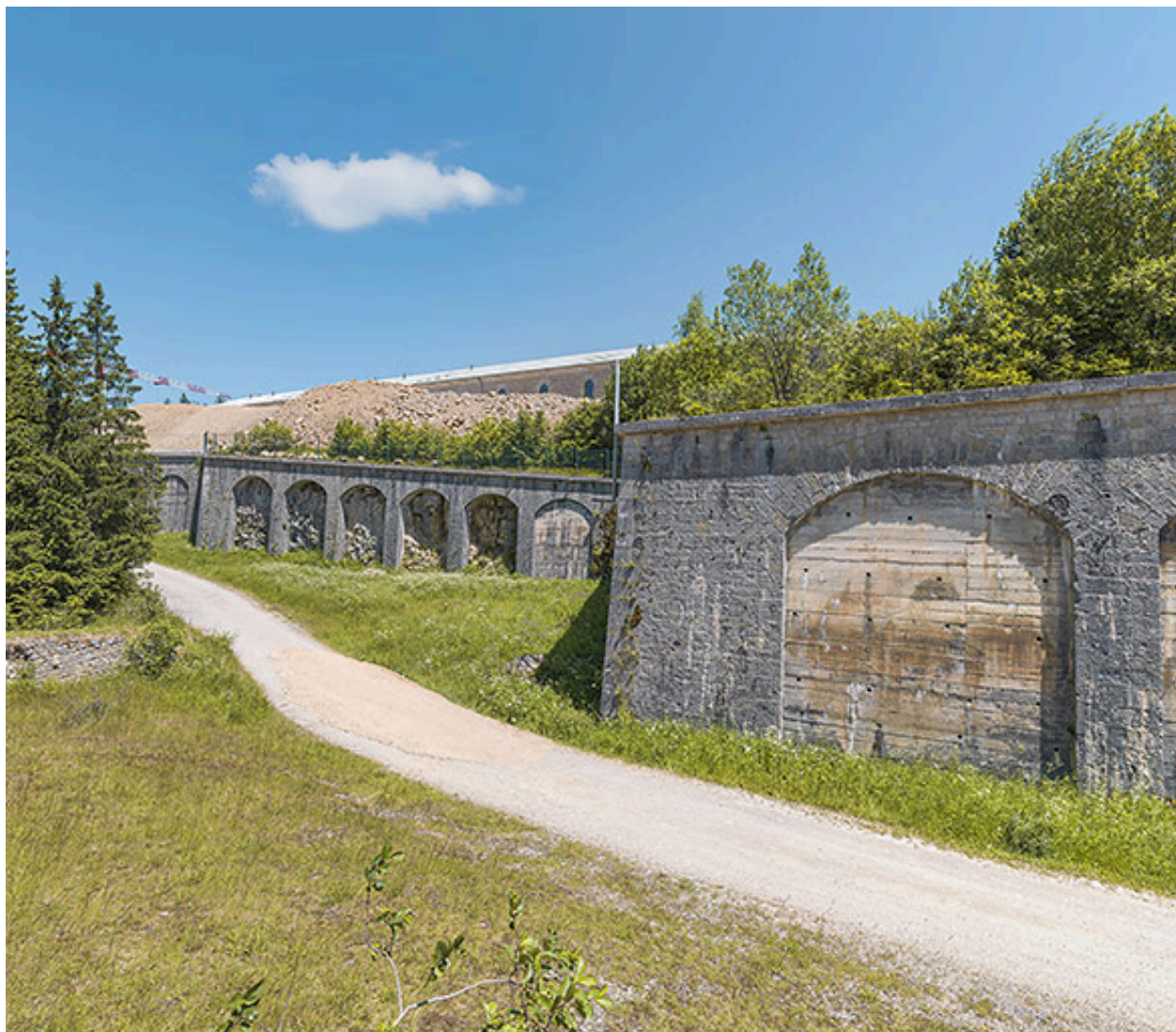
Front ouest : détail d'un arc de décharge hourdis de béton.
