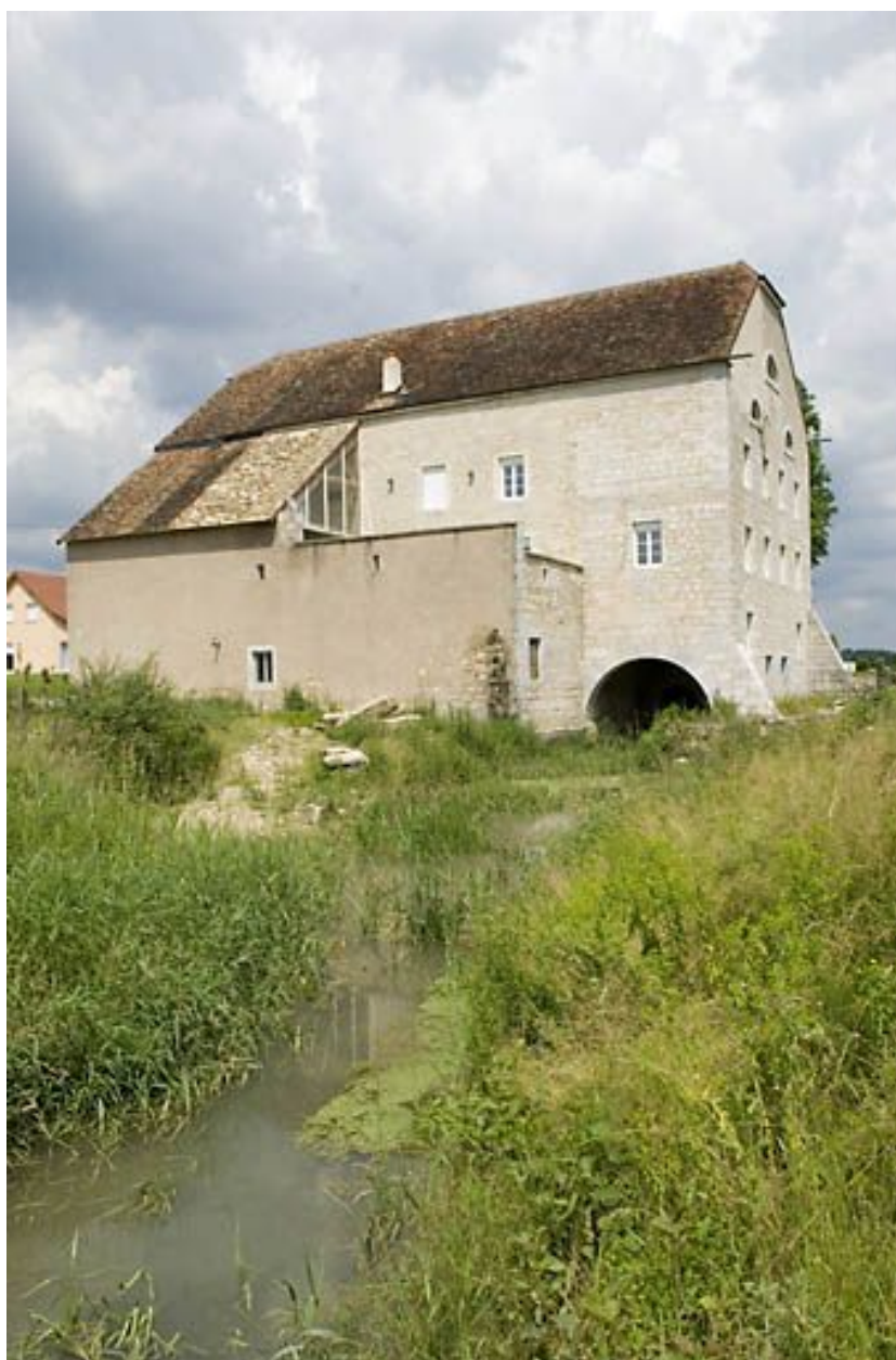
Vue d'ensemble depuis le bief d'aval.
