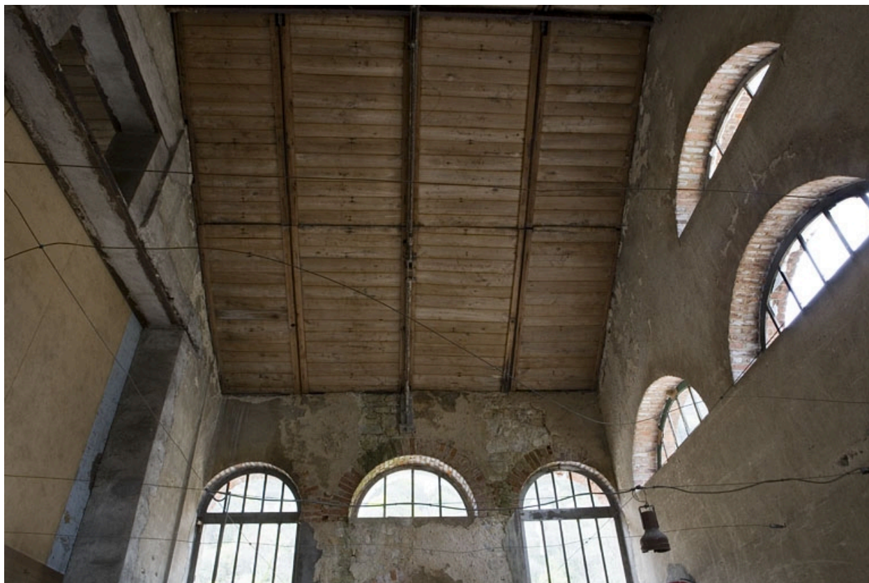
Atelier de réparation. Vue intérieure.
