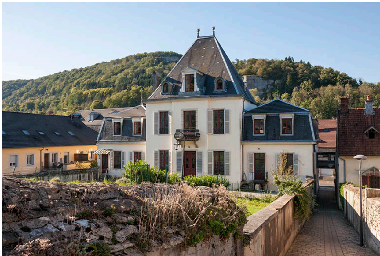
Logement patronal. Façade postérieure.
