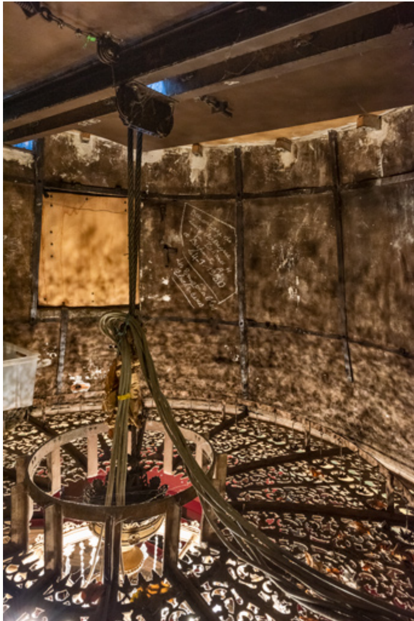
Comble de la salle, cheminée d'aération : intérieur.
