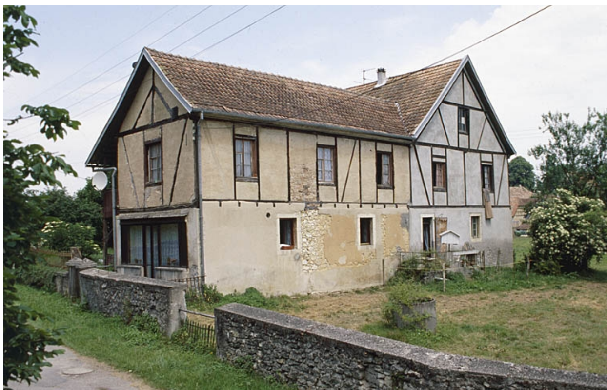
Façade postérieure du logement.
