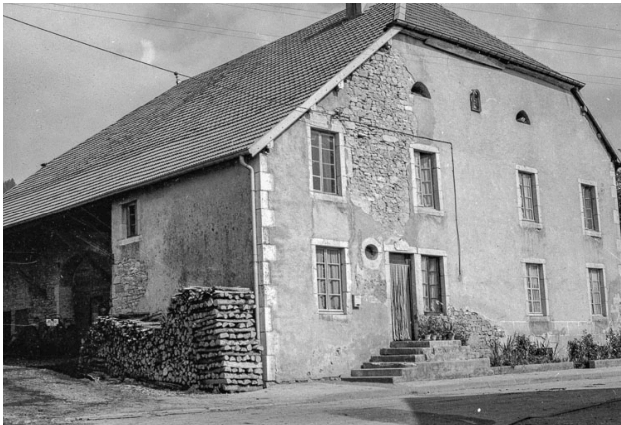
Façades antérieure et latérale gauche.
