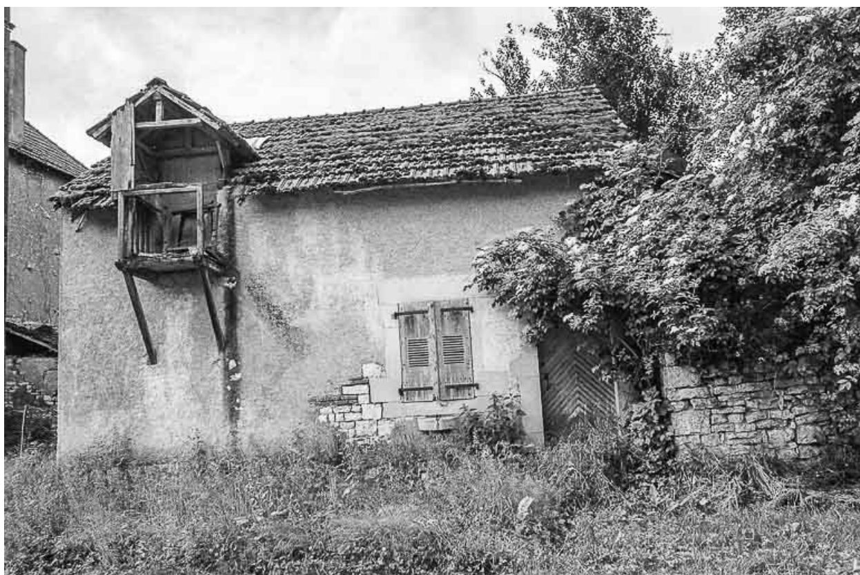
Maison cadastrée 1979 AB 10 : façade antérieure.
