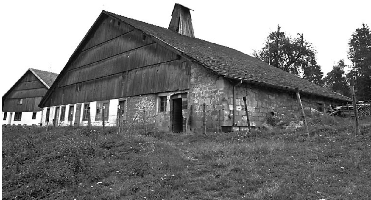
Ferme située au lieu-dit Le Bois du Four.
