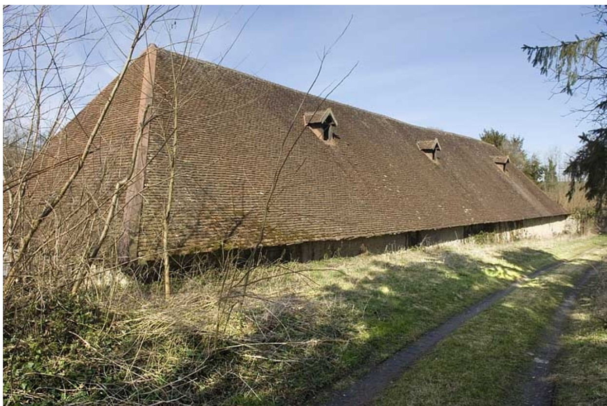
Halle à charbon depuis le sud-est.
