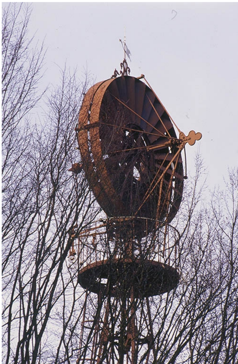
Détail : la passerelle sommitale et l'aéromoteur.
