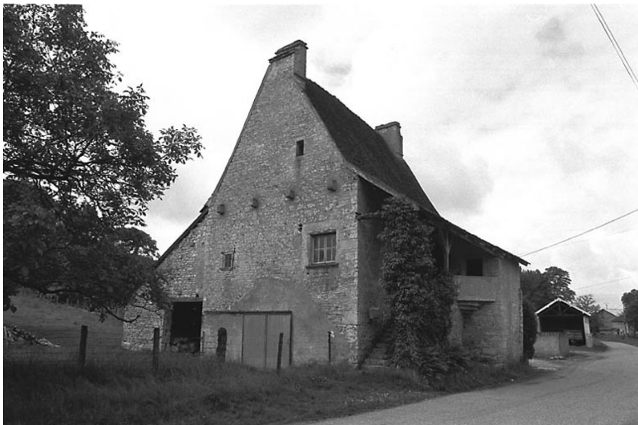
Chevigny, maison située rue de l'Eglise.
