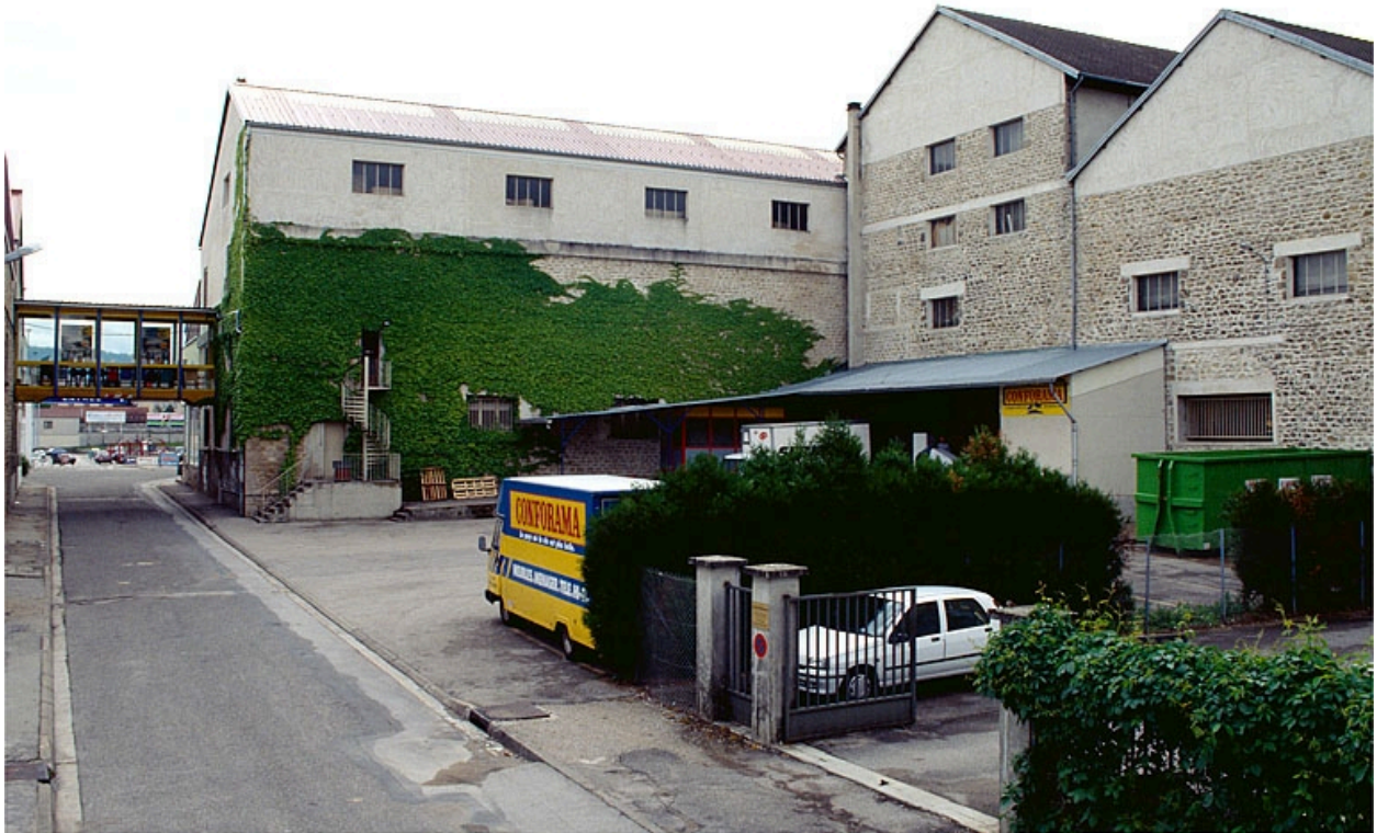
Atelier de fabrication depuis le nord-ouest.
