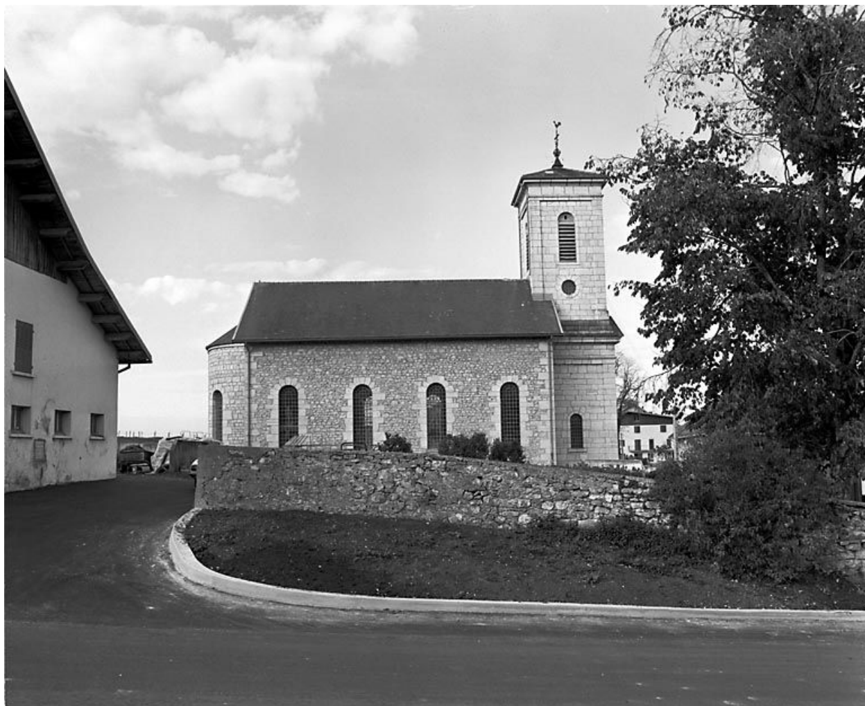
Façade latérale droite.
