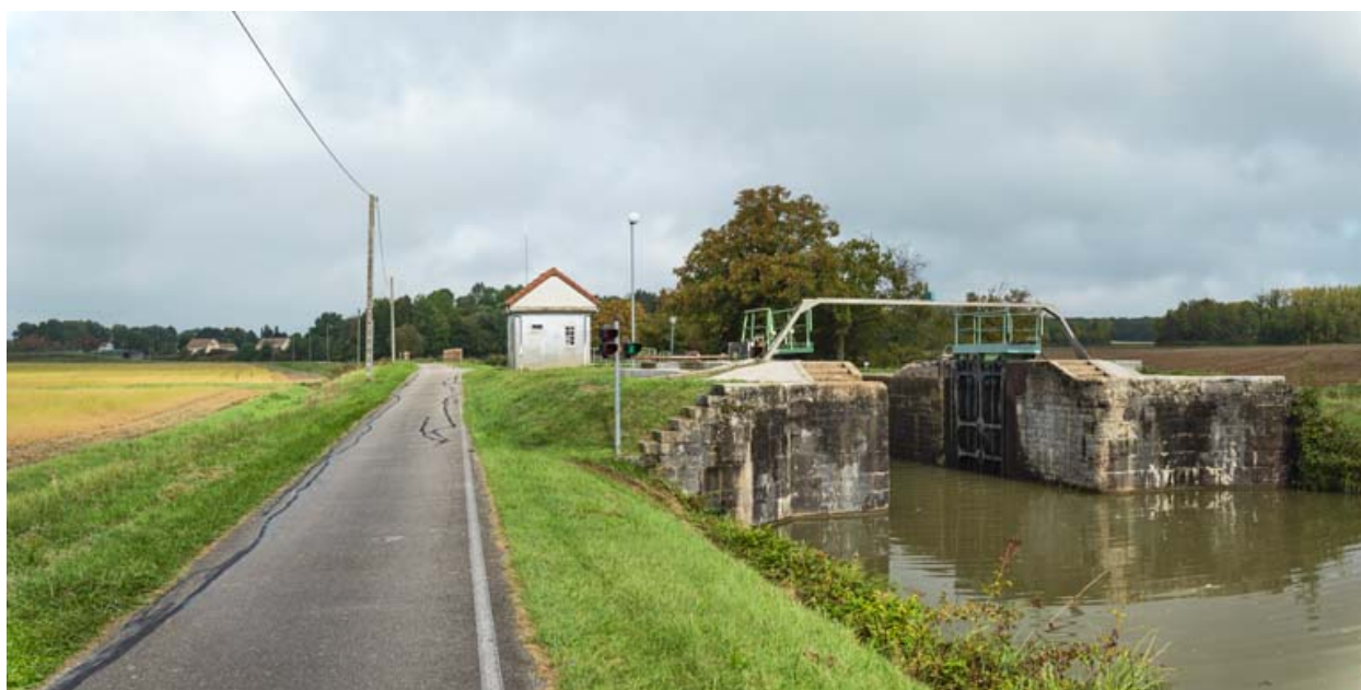
Vue de l'écluse.
