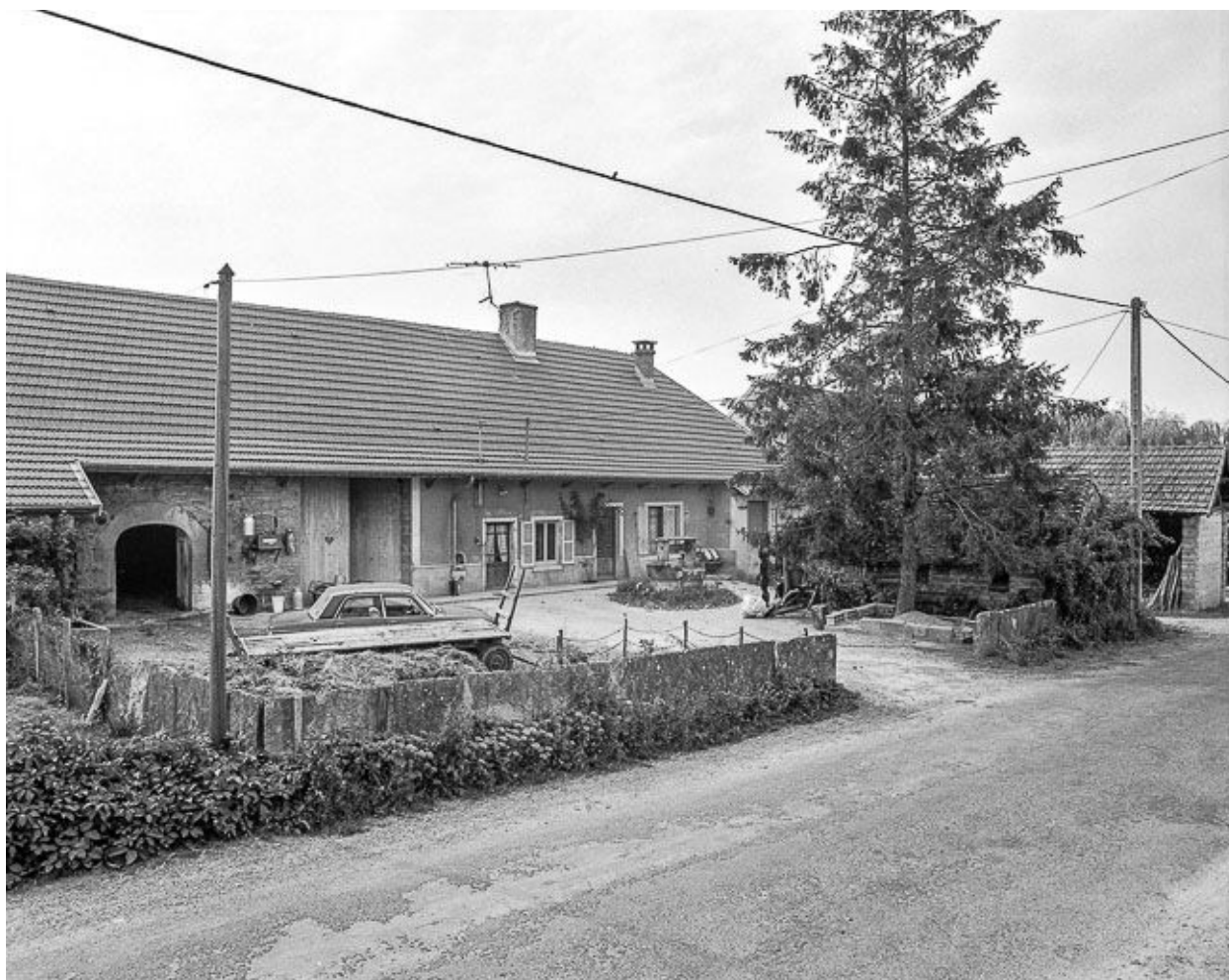
Ferme située rue du Centre.
