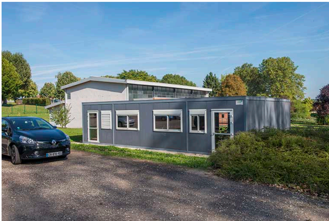
Angle sud du préfabriqué ouest.
