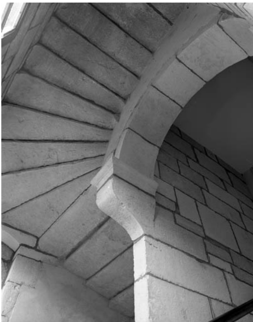
Détail d'une volée d'escalier.
