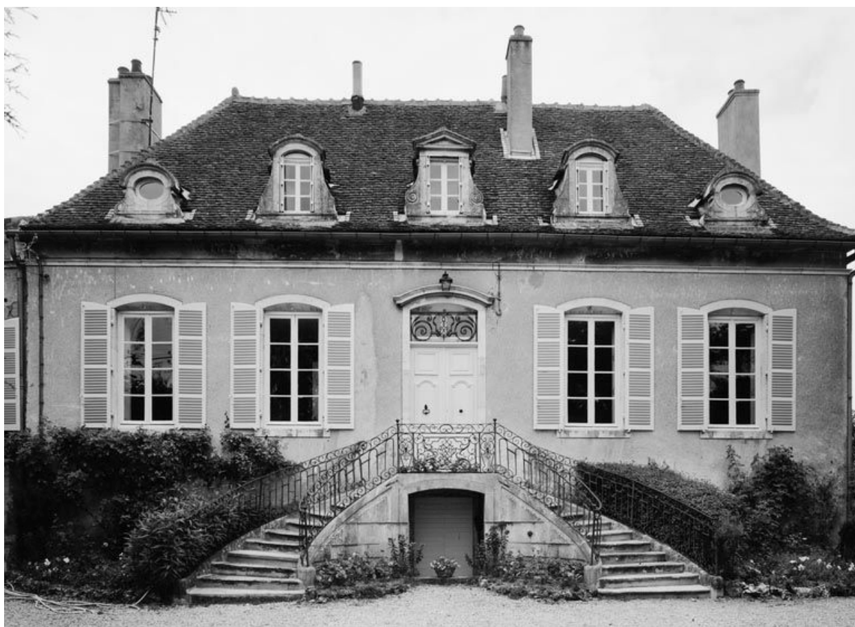
Vue de la façade.
