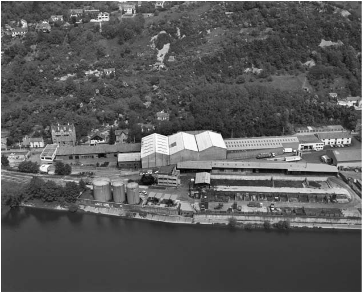
Extrémité nord de l'usine B et entrepôts de combustibles de la société Rhin-Rhône.
