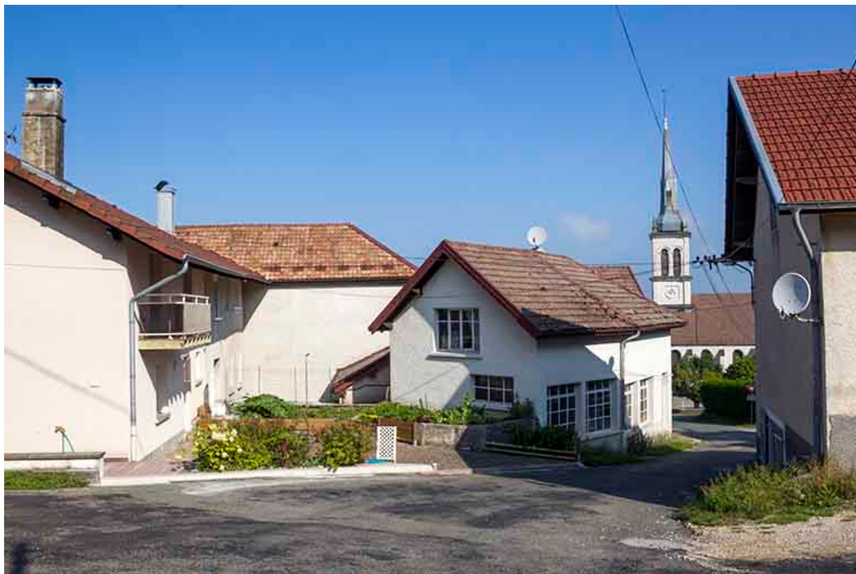
Façades postérieure et latérale gauche.
