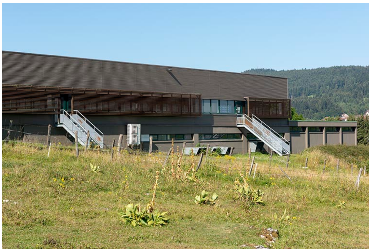
Façade postérieure : escaliers extérieurs vers l'angle nord-ouest.
